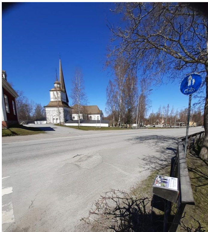
Pedersöre kyrka Tingshusvägen-Vasavägen 116
